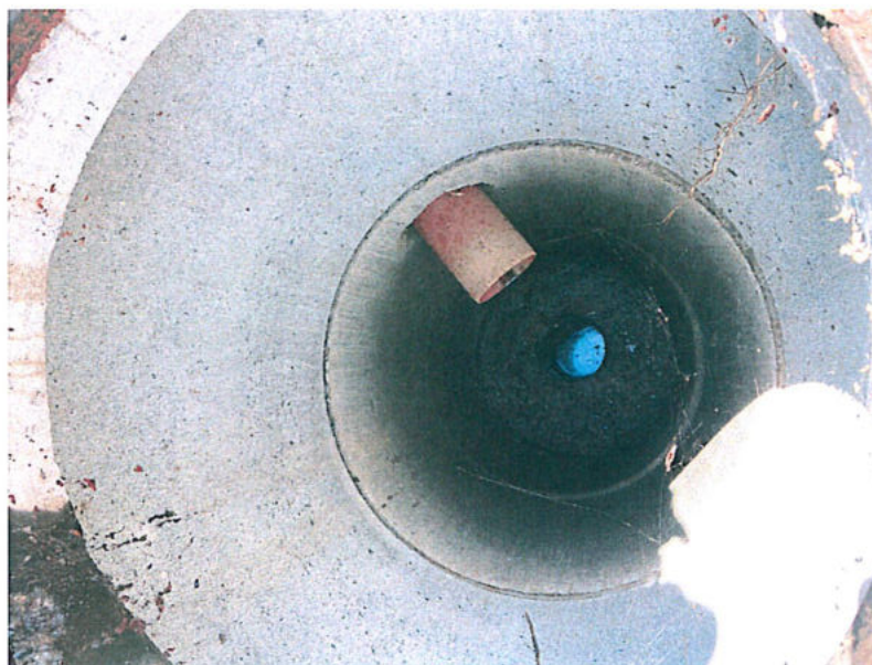
2.2.2 Camin vizitare C4, amplasat pe colectorul de canalizare cu Dn 600 mm
